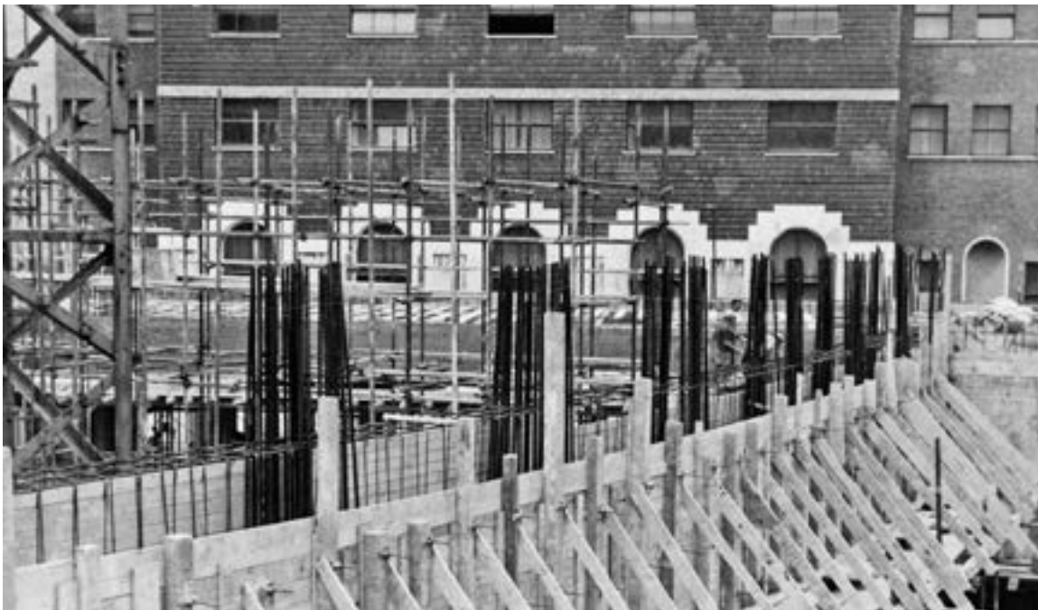
Trieste, via Giustiniano. 1970-1971. Sistemazione, allargamento e restauro dell'edificio che diventerà sede del Consiglio Regionale. Intervento su progetto degli architetti Umberto Nordio e Aldo Cervi realizzato dall'impresa edile di costruzioni Carena Spa. Documentazione fotografica dell'impresa costruttrice: fasi dell'edificazione della nuova ala, situata posteriormente al palazzo preesistente, che accoglie anche l'aula consiliare. Foto dell'Archivio fotografico storico-istituzionale del Consiglio regionale.
